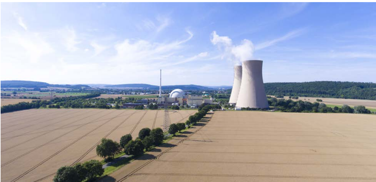
Grohnde NPP (Image: PreussenElektra)
